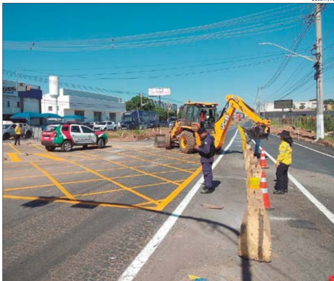
Medidas buscam dar maior fluidez no tráfego durante as obras de readequação da pista
