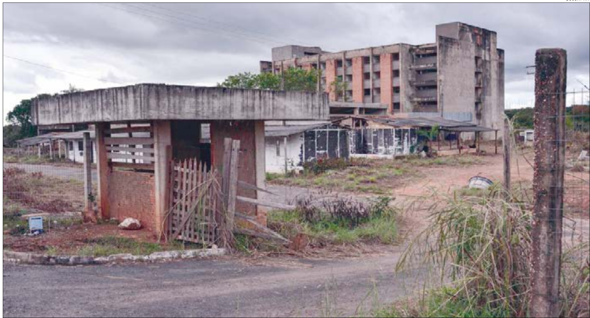
Governo prevê investimento de R$ 102 milhões para concluir as obras do Hospital Central, com abertura de 290 leitos
