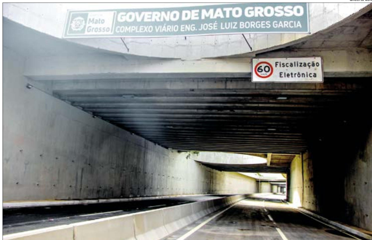
O elevado faz parte do pacote de obras para a Copa de 2014 e ficou sete meses interditado para recuperação
