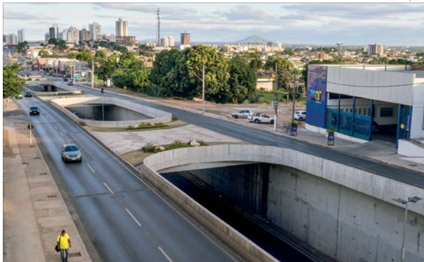
Será preciso remover cerca de 1,5 metro de solo na parte inferior para corrigir infiltração
