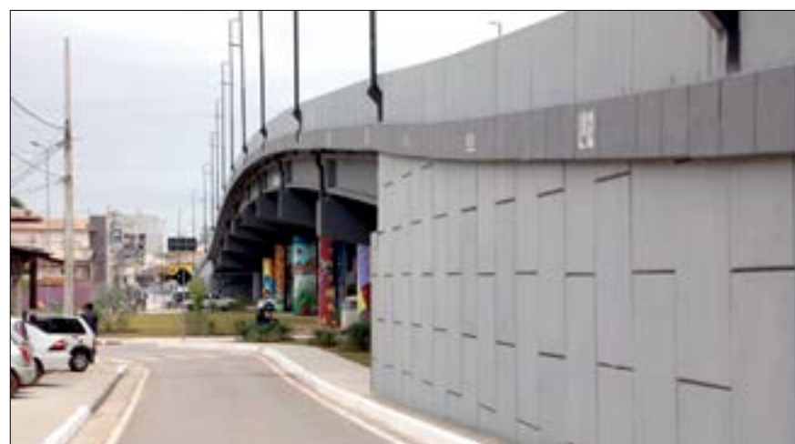
Mais de mil empregos foram gerados durante a construção, movimentando também o comércio ao redor
