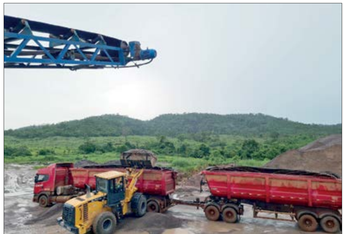
As equipes estão trabalhando 24h por dia na manutenção do trecho não pavimentado da BR-158 em Mato Grosso
