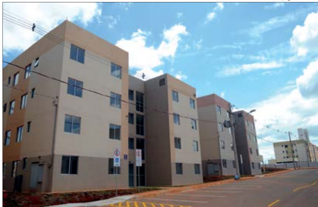
Na região Centro-Oeste, 349 imóveis estão à venda com descontos de até 70%
