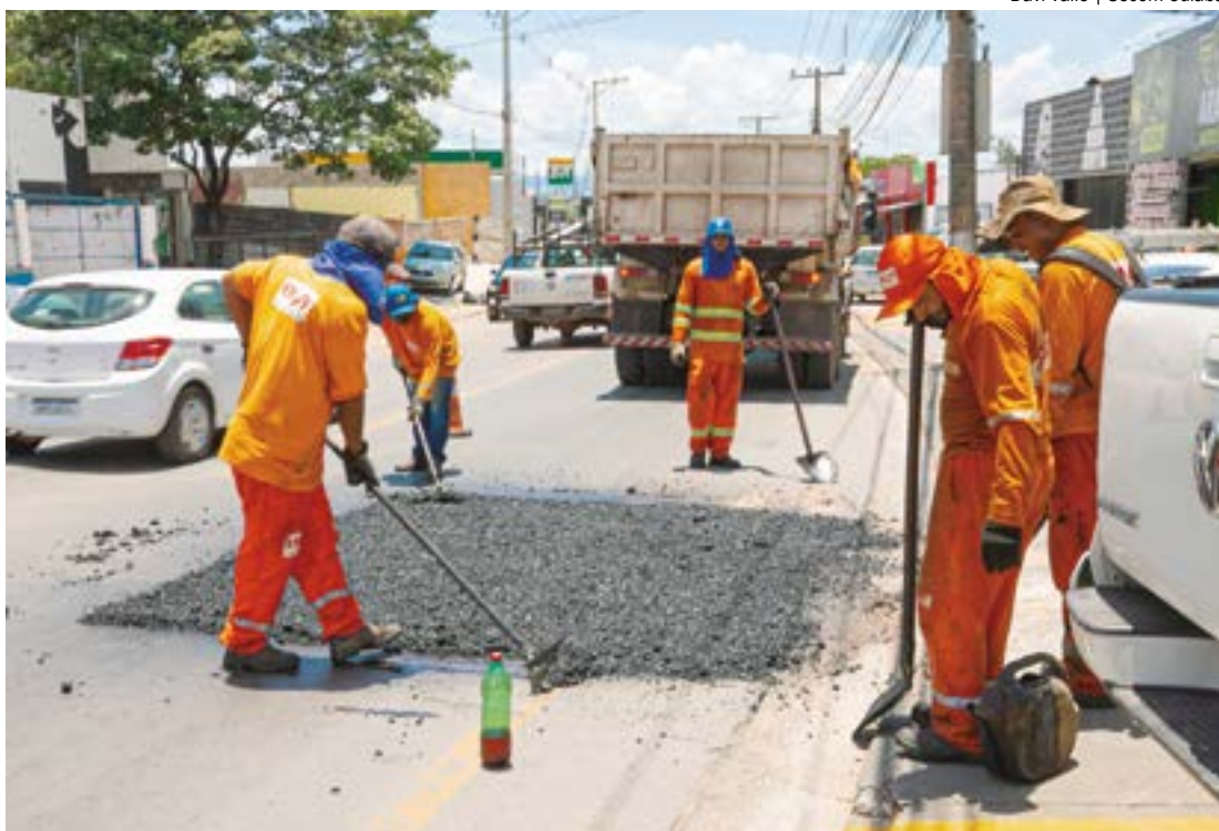
Ao todo, cerca de 1,3 km da avenida receberá as equipes da Secretaria de Obras Públicas
