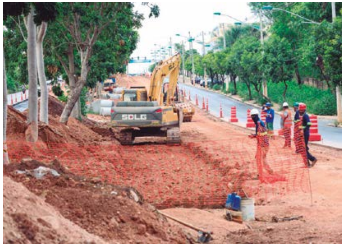
CDL Cuiabá identificou que 90% das empresas foram impactadas negativamente pelas obras
