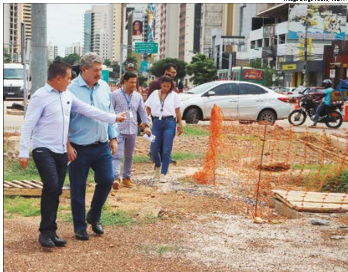
Sérgio Ricardo sugeriu a contratação emergencial de uma nova empresa para garantir a conclusão das obras
