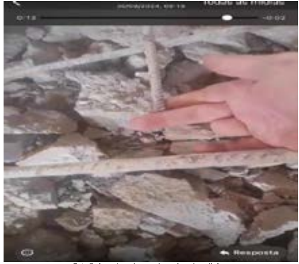
Foto 7: Armadura da escada, após a demolição
