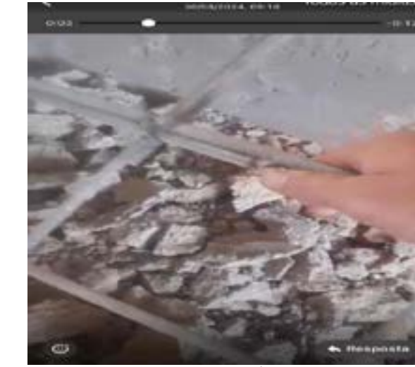
Foto 8: Armadura da escada, após a demolição
