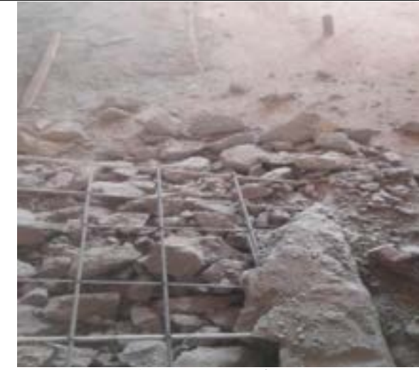
Foto 10: Armadura da escada, após a demolição
