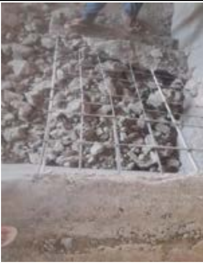
Foto 12: Armadura da escada, após a demolição
