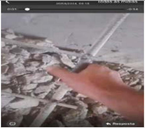
Foto 9: Armadura da escada, após a demolição
