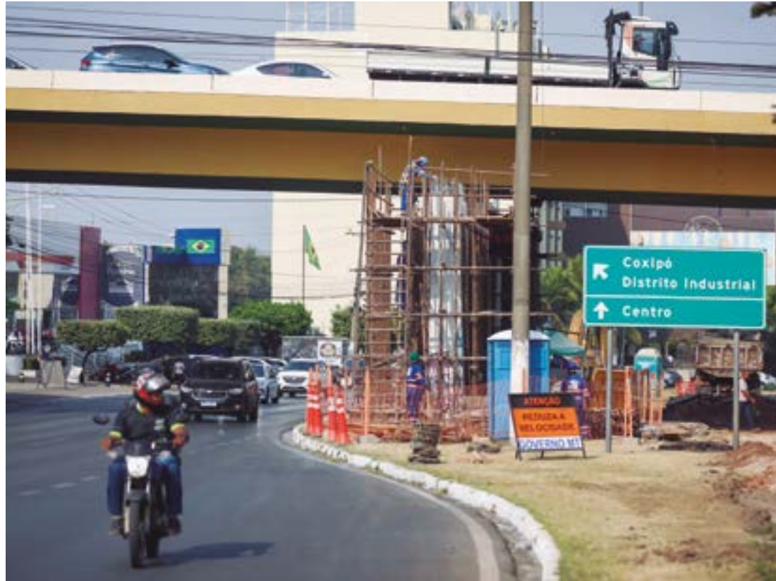
Um caminhão irá descarregar as vigas para ampliação do viaduto, enquanto um guindaste será utilizado para içá-las
