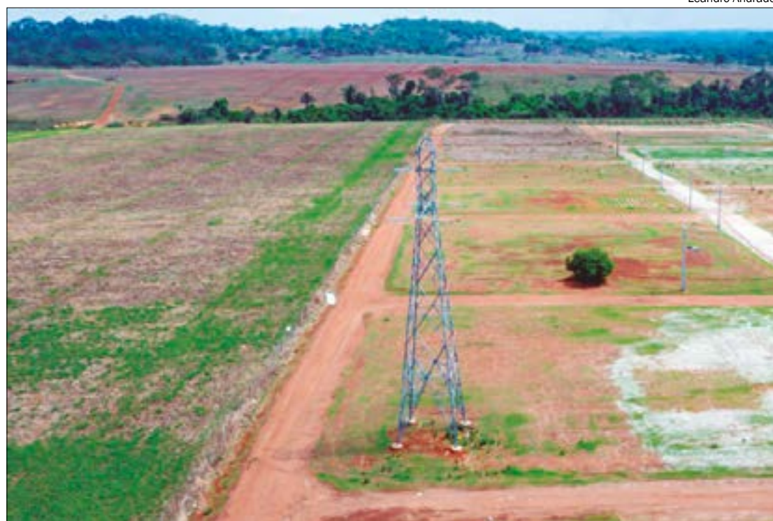
Problemas agravaram e comprometem o funcionamento de equipamentos essenciais para a produção agrícola
