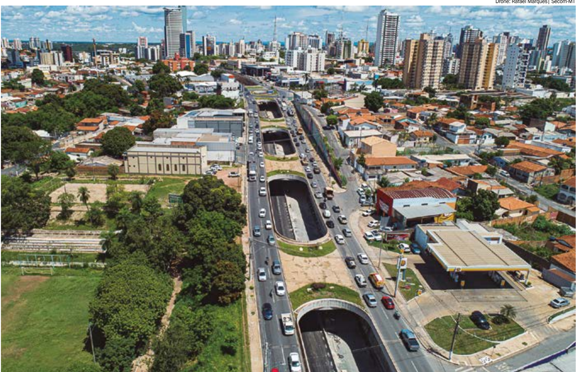
Drone: Rafael Marques | Secom-MT
