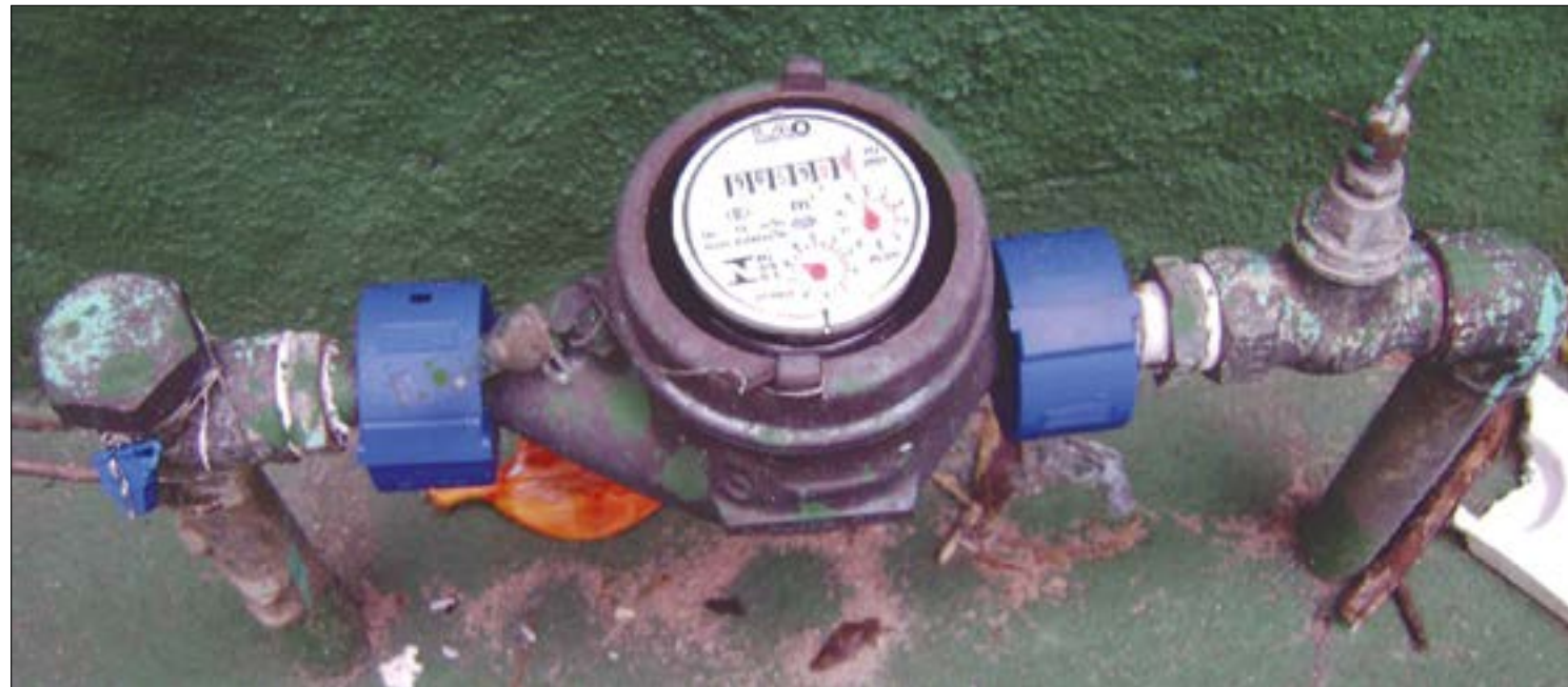
Moradores filmaram o hidrômetro girando com a passagem de ar ao invés de água
