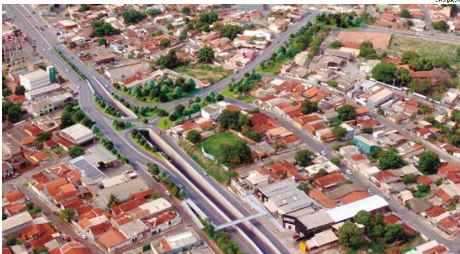
Projeto prevê construção de uma nova trincheira na entrada do Jardim Leblon
